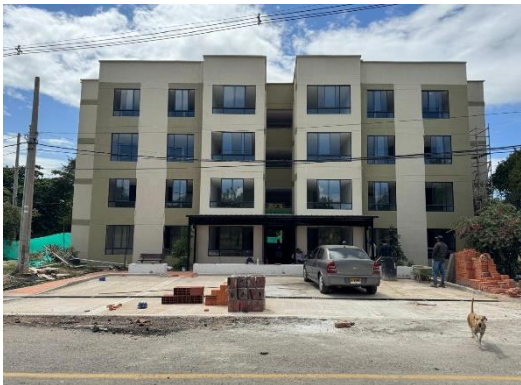
FOTOGRAFÍA FACHADA PRINCIPAL
