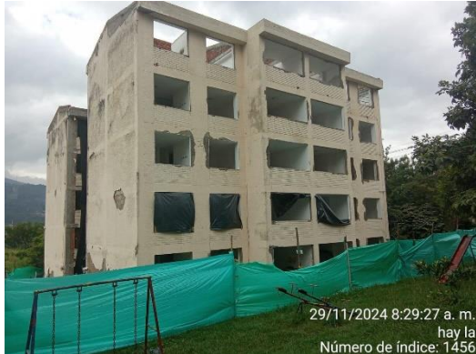
FOTOGRAFÍA FACHADA PRINCIPAL
