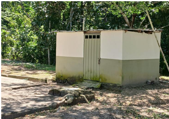
Caseta de Equipos y Tanque de agua subterráneo
