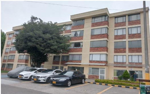
FOTOGRAFÍA FACHADA PRINCIPAL
