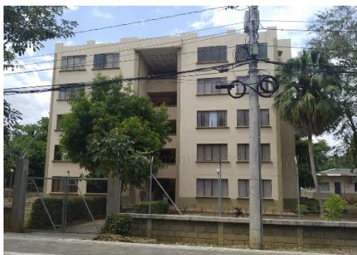
FOTOGRAFÍA FACHADA PRINCIPAL
