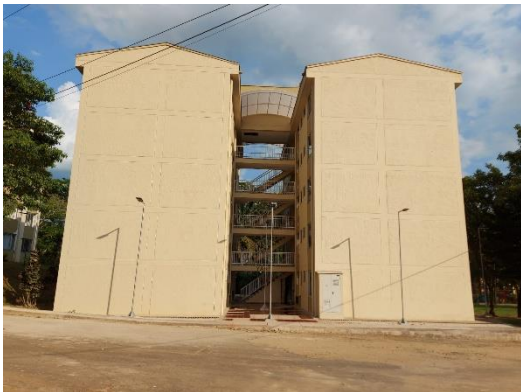
FOTOGRAFÍA FACHADA PRINCIPAL
