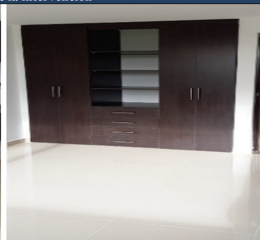
Habitación después de la intervención
