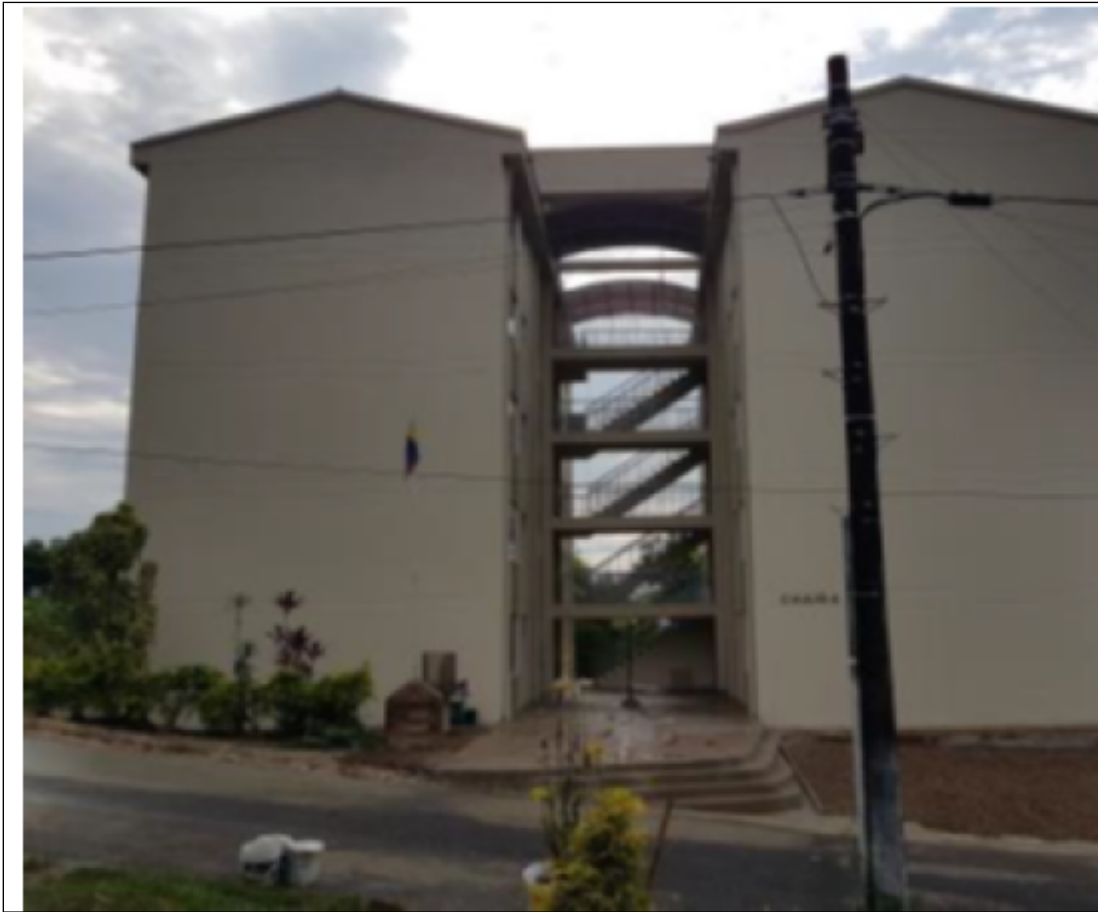
Fachada después de la intervención
