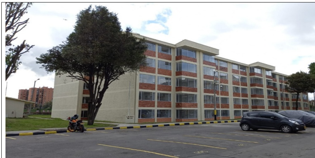
Fachada después de la intervención
