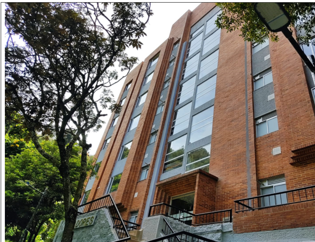
Fachada después de la intervención
