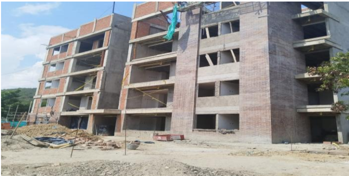
Construcción Edificios de vivienda fiscal seccional de Cúcuta
