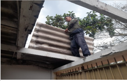
Reparación de goteras
