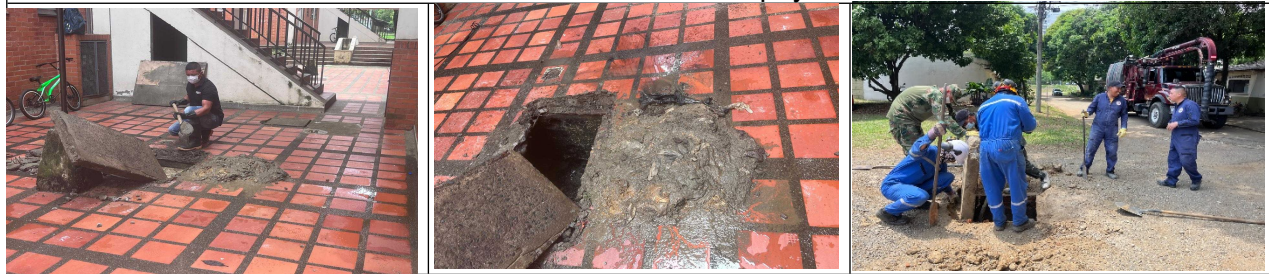
Limpieza de cajas de aguas negras
