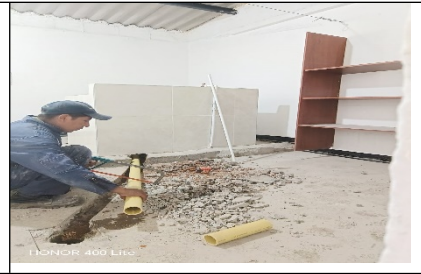
Cambio de drenaje
