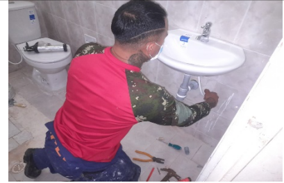
Cambio de baterías de baño y duchas
