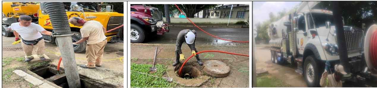
Mantenimiento de red sanitaria con apoyo del VACTOR
