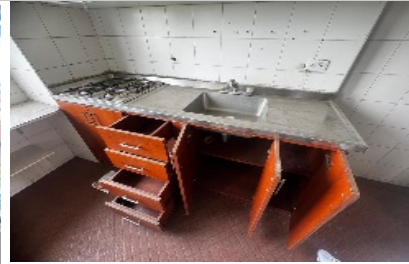
Mejoramiento de casinas
