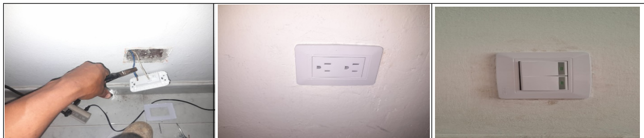
Cambio de tomacorrientes y interruptores
