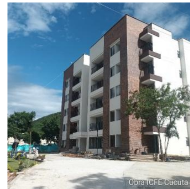
Obra ICFE Cucuta N
