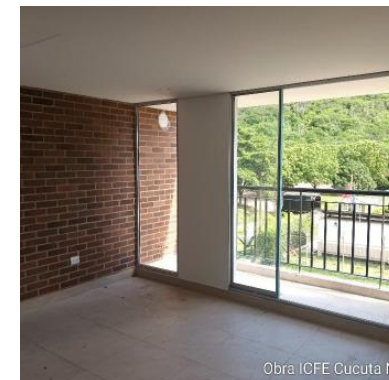
Obra ICFE Cucuta N
