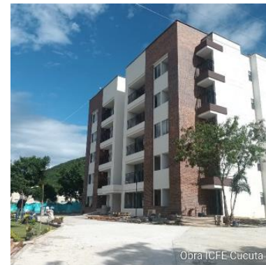
Obra ICFE Cucuta N
