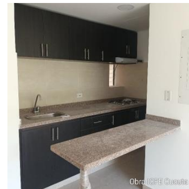
Obra ICFE Cucuta N
