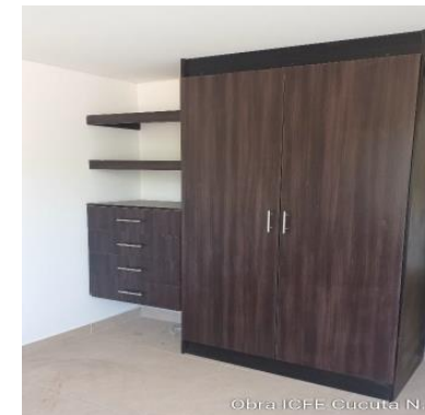
Obra ICFE Cucuta N
