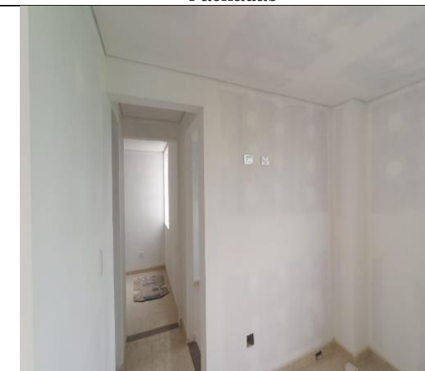
Estuco y pintura
