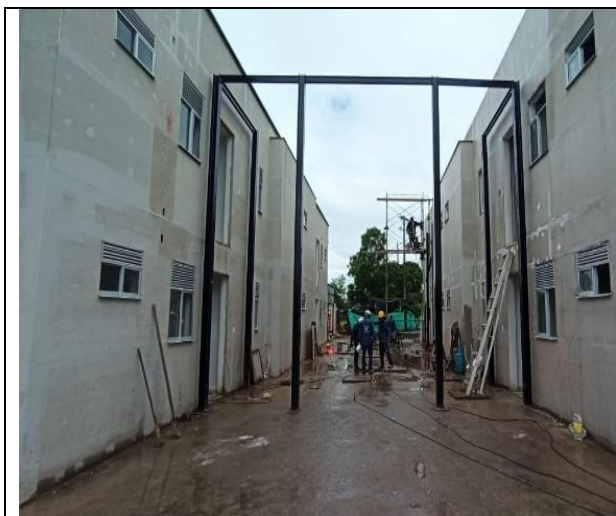
Estructura Metálica Punto Fijo
