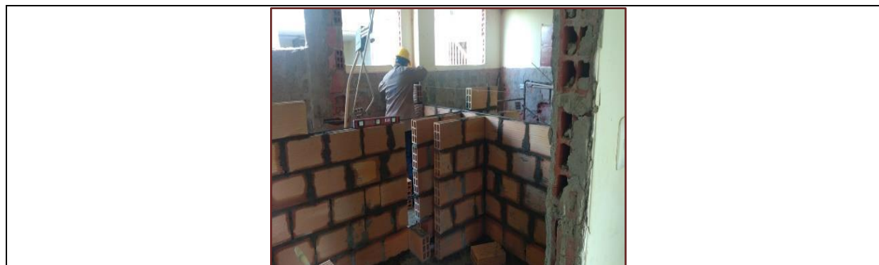
ELABORACION DE MUROS EN MAMPOSTERIA
