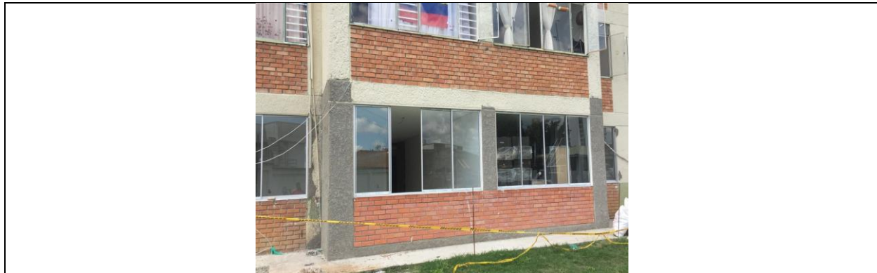
ELABORACION DE MUROS EN MAMPOSTERIA EN FACHADA
