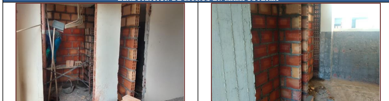
CONFINAMIENTO DE MUROS
