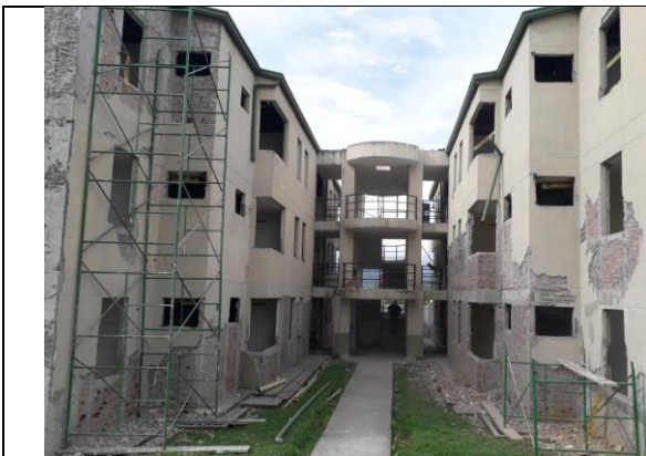
Demolicion pañete fachadas interiores
