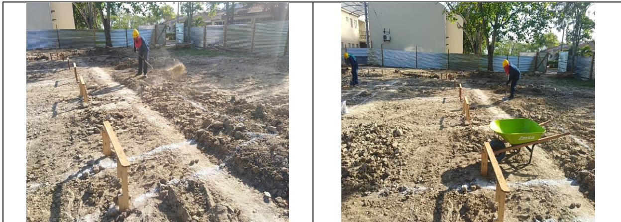
Trazado y replanteo
