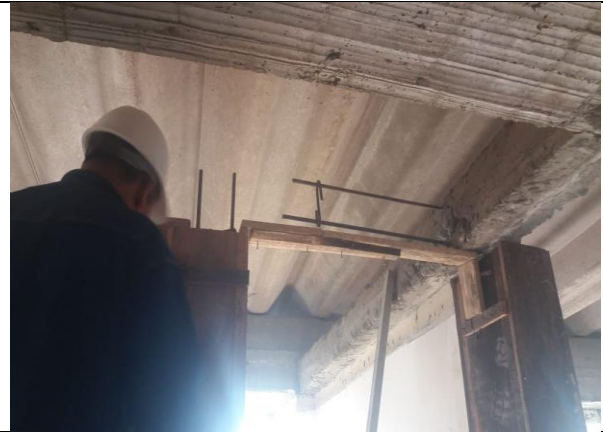
Vigas de confinamiento
