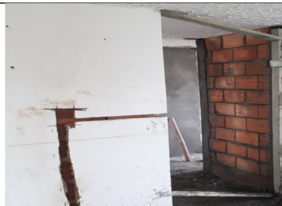
Construcción muros internos y regatas
