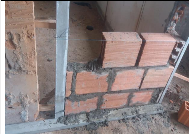
Construcción muros mampostería
