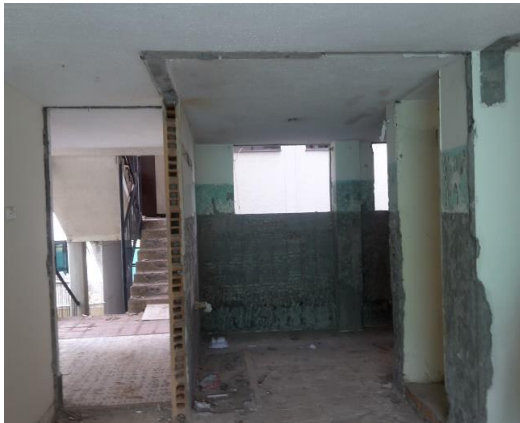
Desmonte de enchapes de pisos y muros
