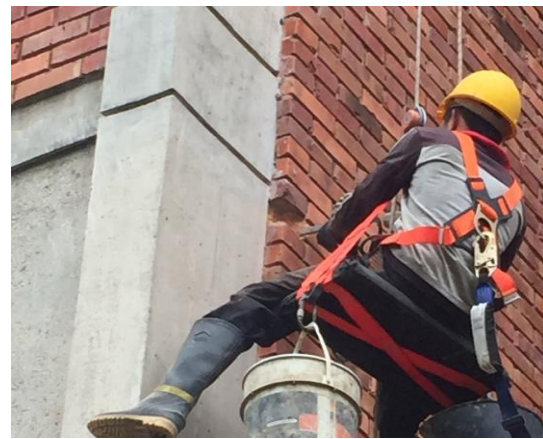
Cambio de piezas de ladrillo en fachada
