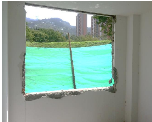
Desmonte de ventanería
