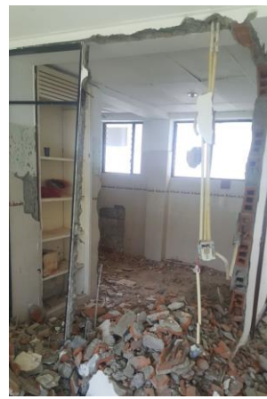
Demolicion de muros
