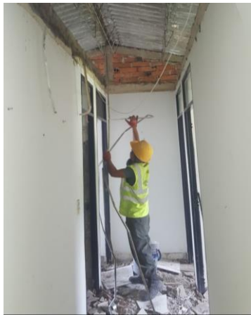
Desmonte de cielorasos
