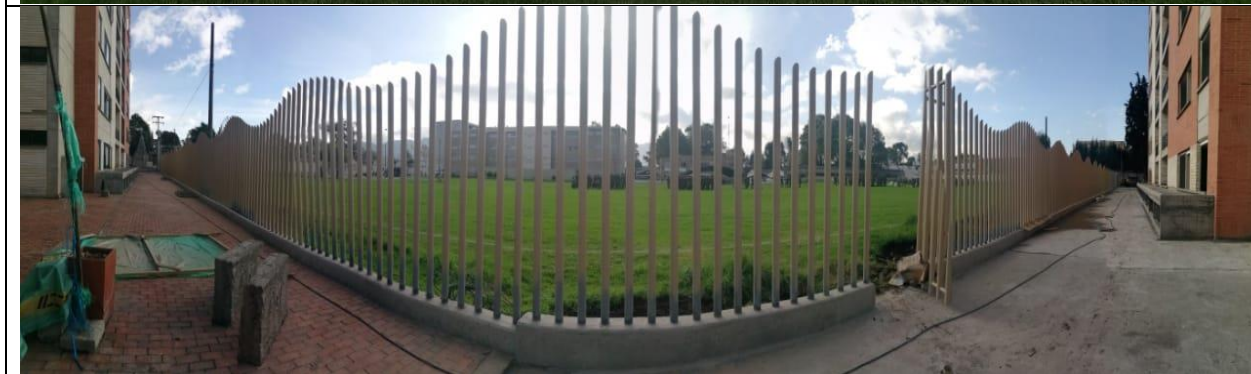
Vista panorámica frontal y posterior cerramiento del conjunto de puente aranda
