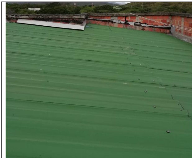
Cubierta edificio de suboficiales seccional cúcuta
