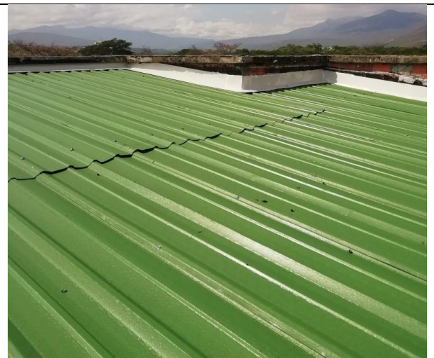
Cubierta edificio de oficiales seccional cúcuta
