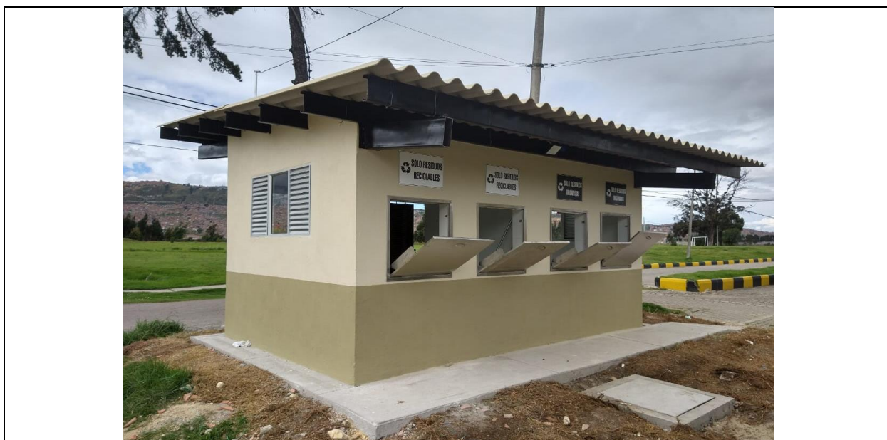
Vista de uno de los cuatro centros de acopio construidos y entregados a satisfacción
