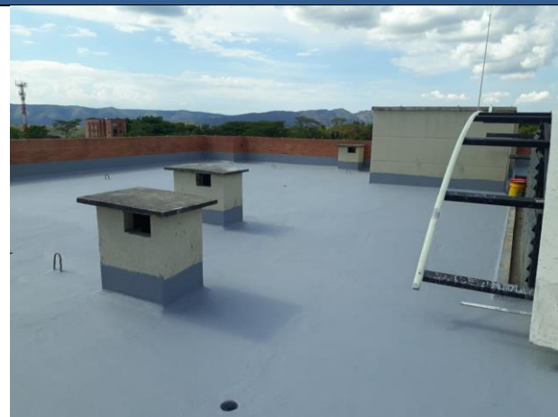
Impermeabilización de cubierta tolemaida
