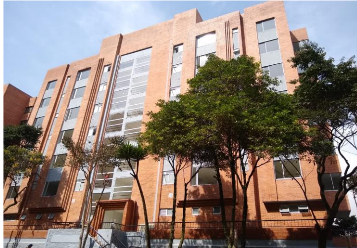
Fachada despues de intervención
