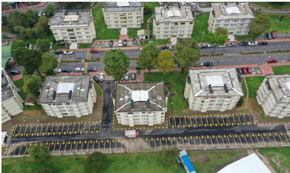
Vista superior del área de parqueaderos terminada
