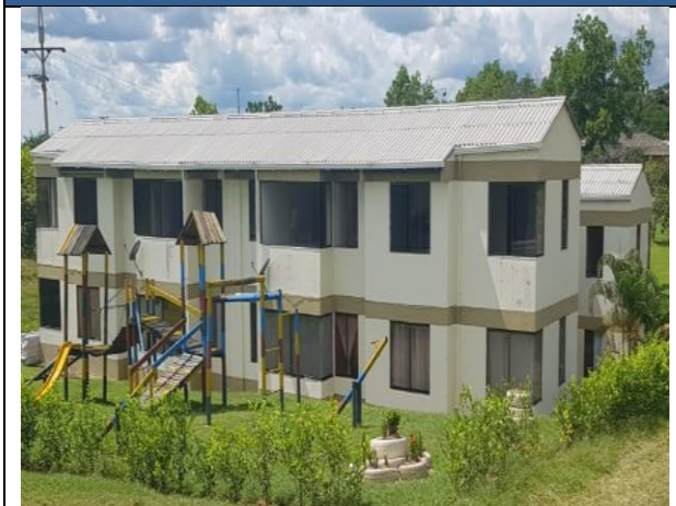
Reemplazo de cubiertas seccional san pedro de urabá
