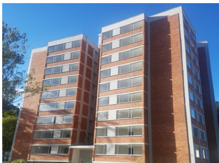
Facha de la edificación
