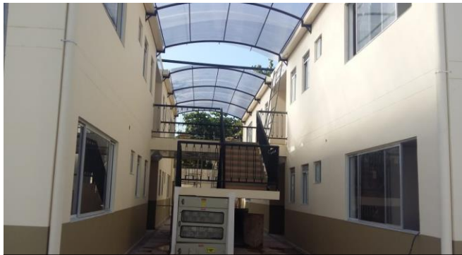
Fachada y punto fijo de la edificación
