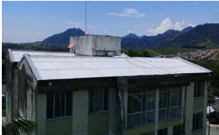
Panorámica actual cubiertas edificaciones
