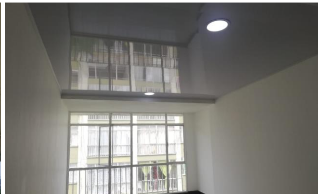
Cielorraso y luminarias apartamentos
