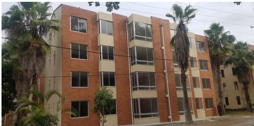
Fachada principal edificación
