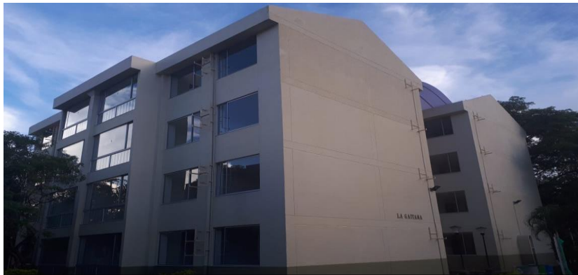
Fachada principal edificación
