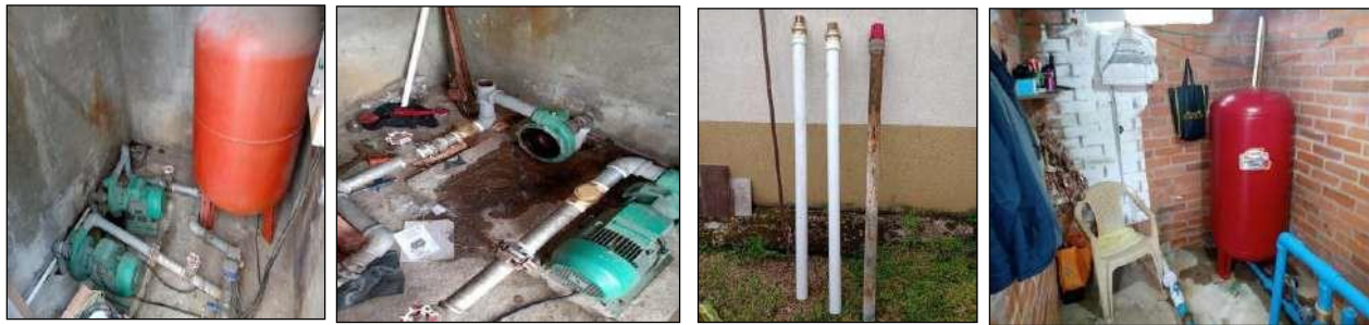
MANTENIMIENTO GENERAL DE TABLEROS, TUBERÍA Y EQUIPOS DE BOMBEO
