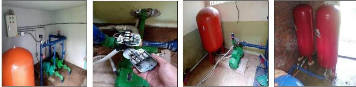
MANTENIMIENTO GENERAL DE TABLEROS, TUBERÍA Y EQUIPOS DE BOMBEO
